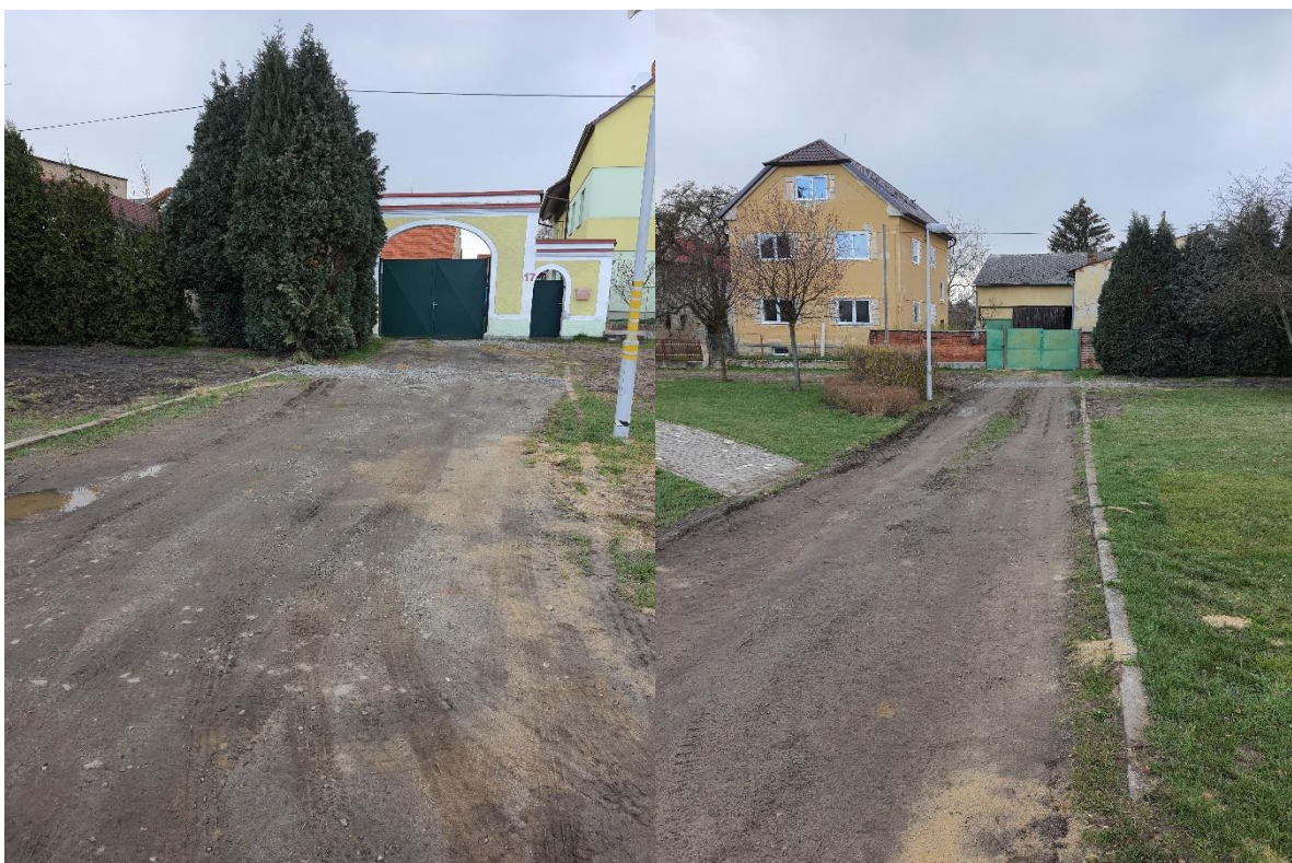
NÍŽE JE PATRNÝ STAV TRÁVNÍKU, CEST A BETONOVÝCH OBRUBNÍKŮ, KTERÉ LEMUJÍ PŘÍSTUPY K RODINNÝM DOMŮM
